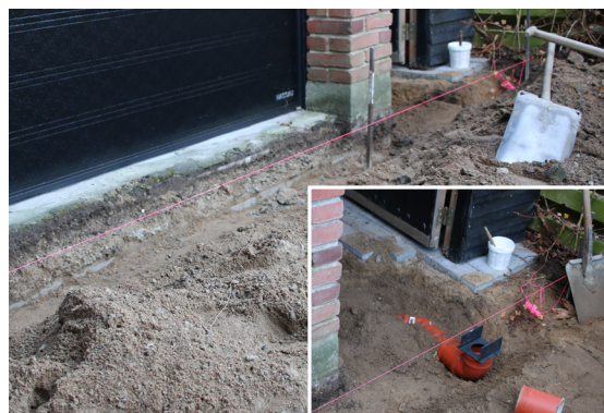
Belægningssten og grus fjernes til ca. 25 cm under færdig niveau. Opføringsrør til afløb etableres til kloak eller faskine.
