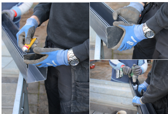
Forbered første rendestykke: Fastmonter endebund med PVC-lim og bor hul til afløb med et kopbor.
