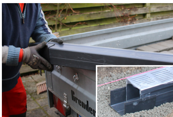
Et samlestykke påført PVC-lim klikkes på enden af renden.
