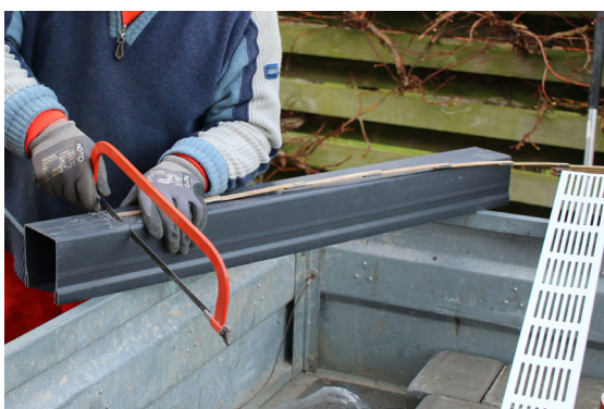
Tilpas det første rendeelement (og rist) i længden efter behov med en nedstryger.
